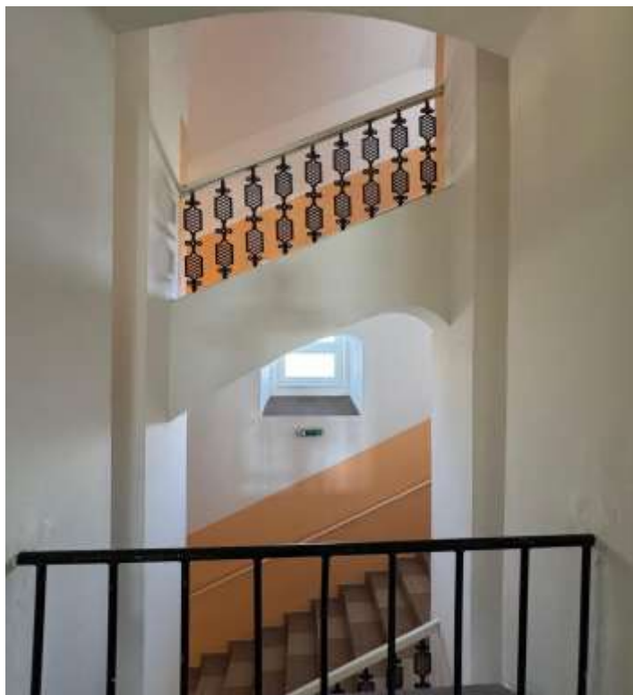
Pohled na schodiště
