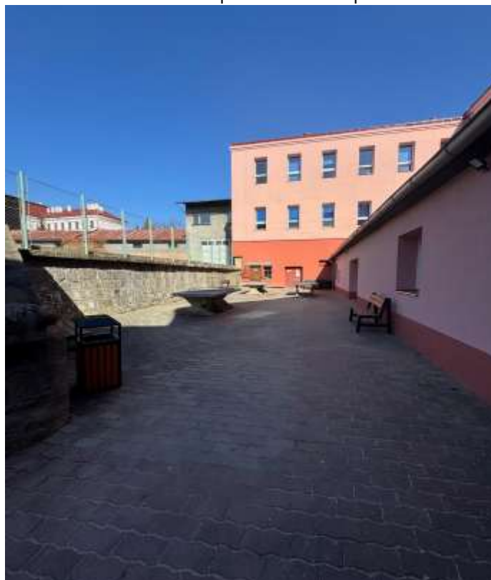
Pohled na dvůr – vpravo vstup do žákovských šaten
